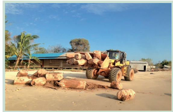
宏發韋立捐助建築材料幫助當地修復受損海岸線
